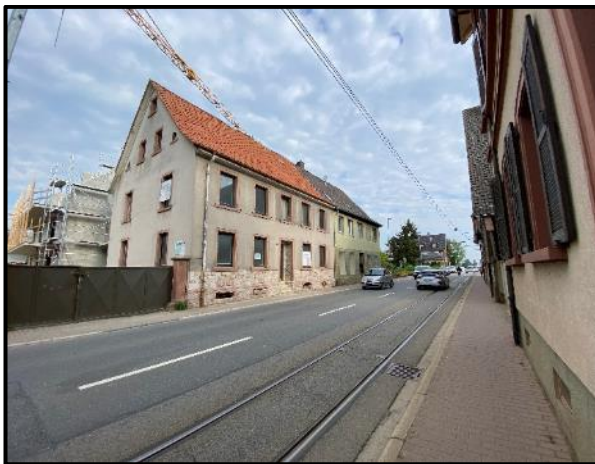
Bauliche Anlagen entlang der östlichen Grenze des Plangeltungsbereich (entlang der Landstraße), Aufnahmerichtung Nordwesten
